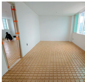
2. 골드랜드 폼 설치-②
