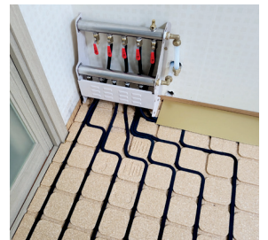
4. 온수관 호스 설치-②
