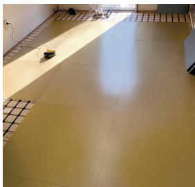
5. 열전도 강판 설치-①
