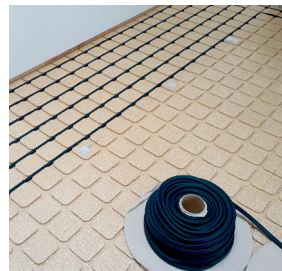
3. 온수관 호스 설치-①
