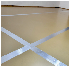
6. 열전도 강판 설치-②
