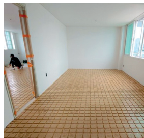
2. 골드랜드 폼 설치-②
