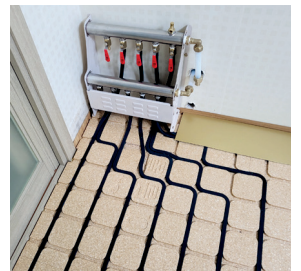
4. 온수관 호스 설치-②
